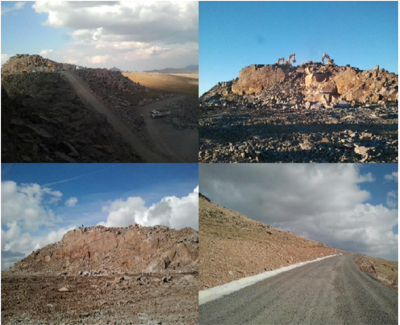
Şekil-1: DAG Yerleşkesi ( hafriyat öncesi-sonrası, 15 m aşağı indirilmiştir ), Bazalt Kayalık, Yol mevcut (Karakaya Tepeleri/Konaklı/Erzurum, 3170 m, 2016).
