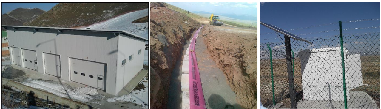
Şekil-3: Enerji Binası (Konaklı, 2016), OG Elektrik Hattı ve Sismik Kabin (Karakaya Tepesi, 2015).
