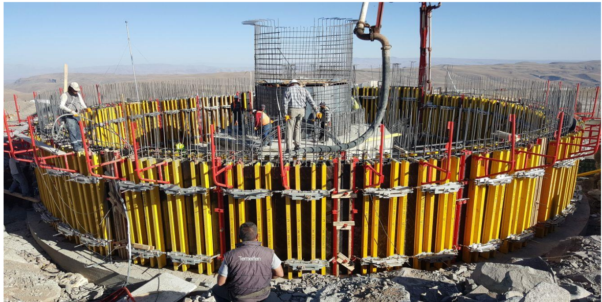
Şekil-2: DAG Binası İnşaatı, DAG Yerleşkesi, Karakaya Tepeleri/Konaklı/Erzurum (3170 m, 2017).
