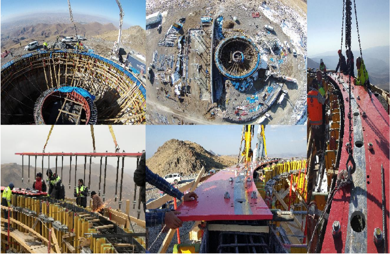
Şekil-4: DAG Binası ve Kubbe Platformu Montajı (Eylül - Ekim 2017).
